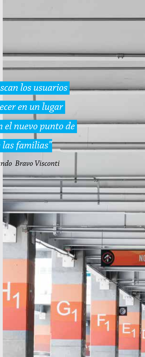
1. La estructura metálica de los estacionamientos fue protegida con recubrimiento intumescente de PPG Comex en complemento.
