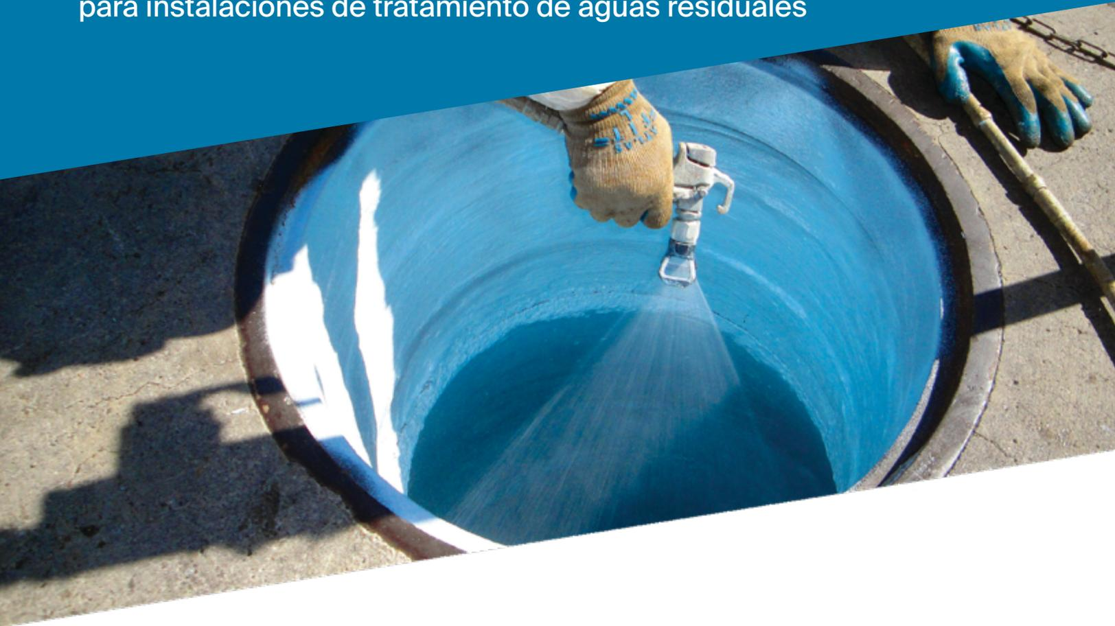
El epóxico **PPG RAVEN 405** es un sistema de revestimiento de ultra alta construcción de película que posee una gran resistencia física y una amplia resistencia a sustancias químicas que le permite resistir ambientes severos y cáusticos.
