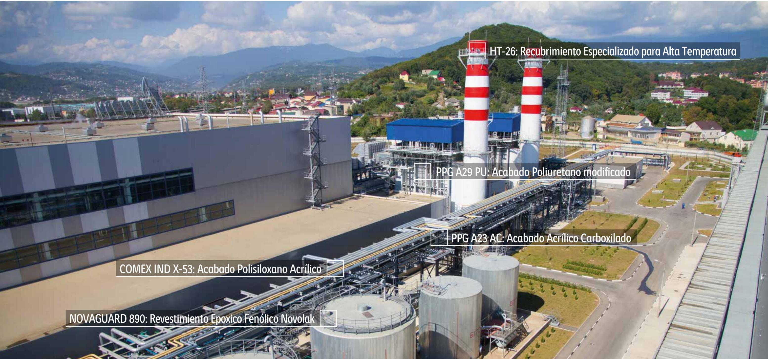
HT-26: Recubrimiento Especializado para Alta Temperatura
