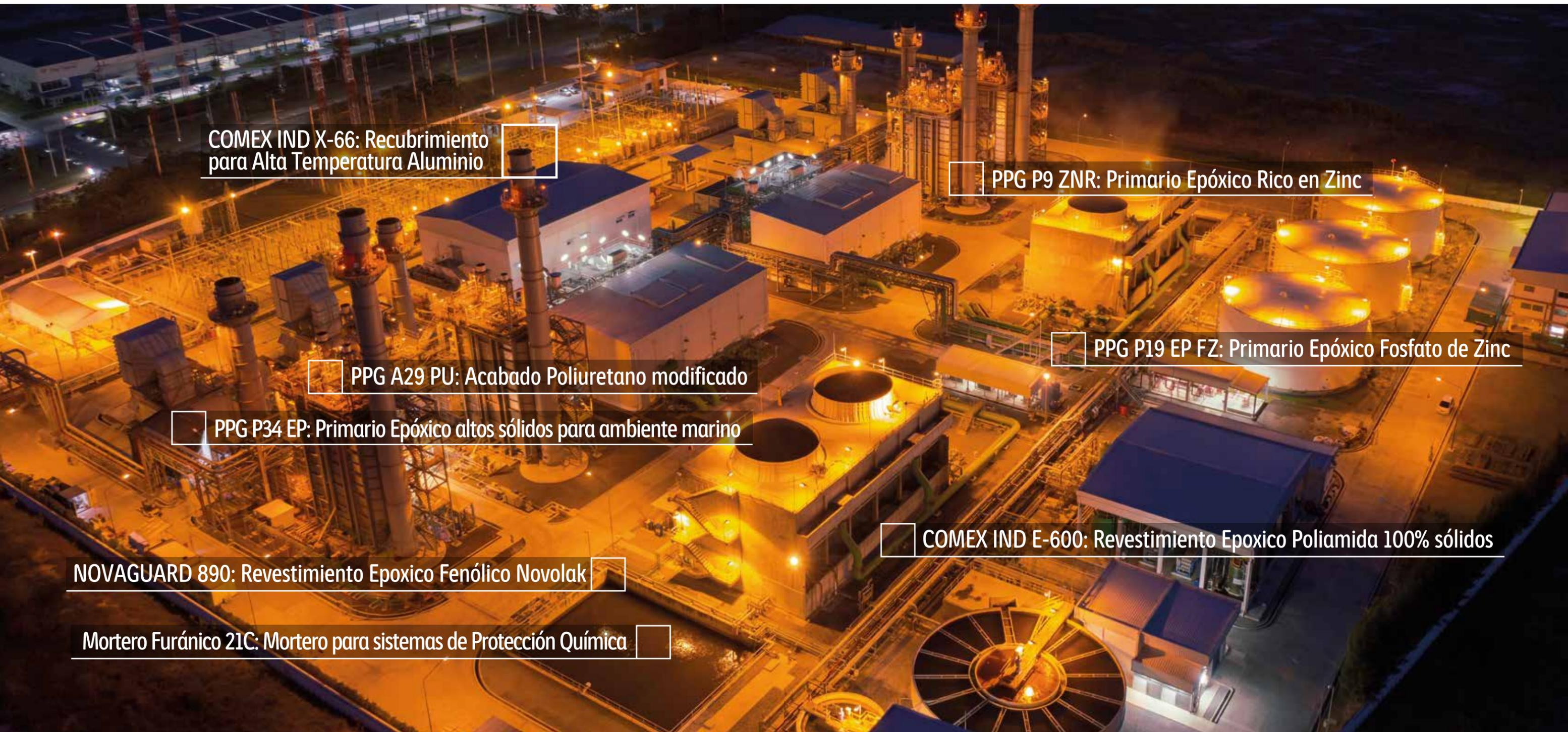
COMEX IND X-66: Recubrimiento para Alta Temperatura Aluminio
