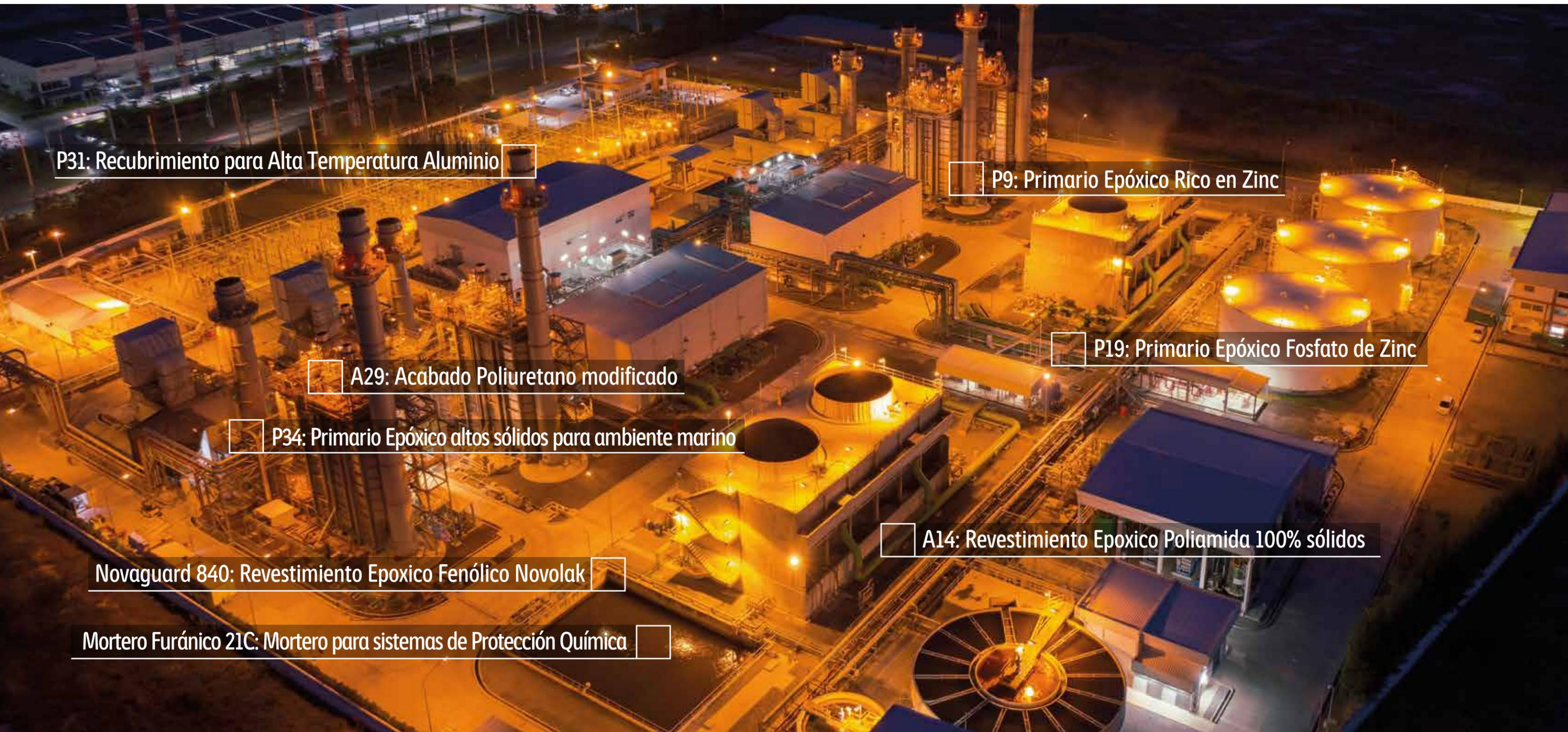
P31: Recubrimiento para Alta Temperatura Aluminio
